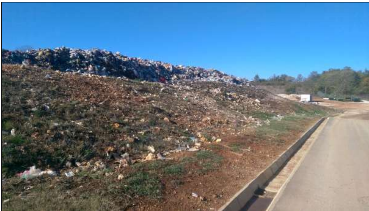
Slika 2.1.-3. Stanje lokacije 2017., vidljiva ploha za odlaganje otpada i obodni betonski kanal.
