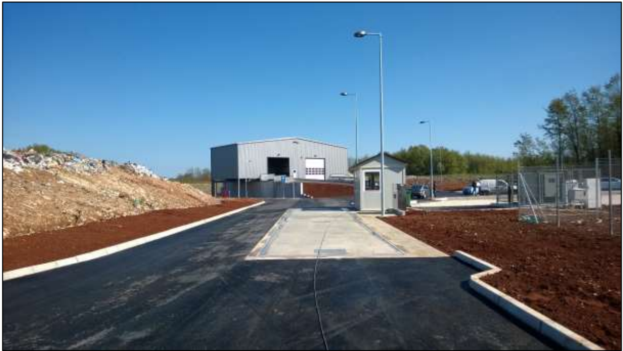
Slika 2.1.-1. Stanje lokacije 2017., lijevo vidljiva ploha za odlaganje otpada, sredina vidljiva izgrađena PS Pazin i kolna vaga, desno u ogradi plato za RD.
